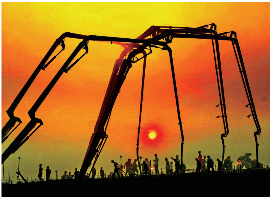
日落时分，施工机械与施工者绘出生机勃勃的剪影。
