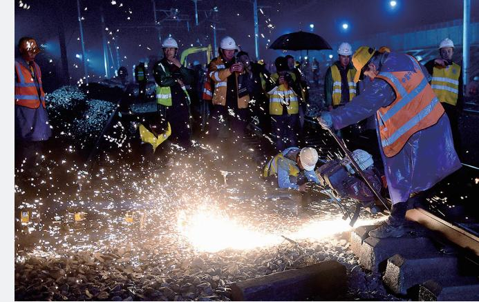
▲ 4月27日凌晨，工人在引江济淮沪蓉高铁改建工程双线拨接现场施工。
