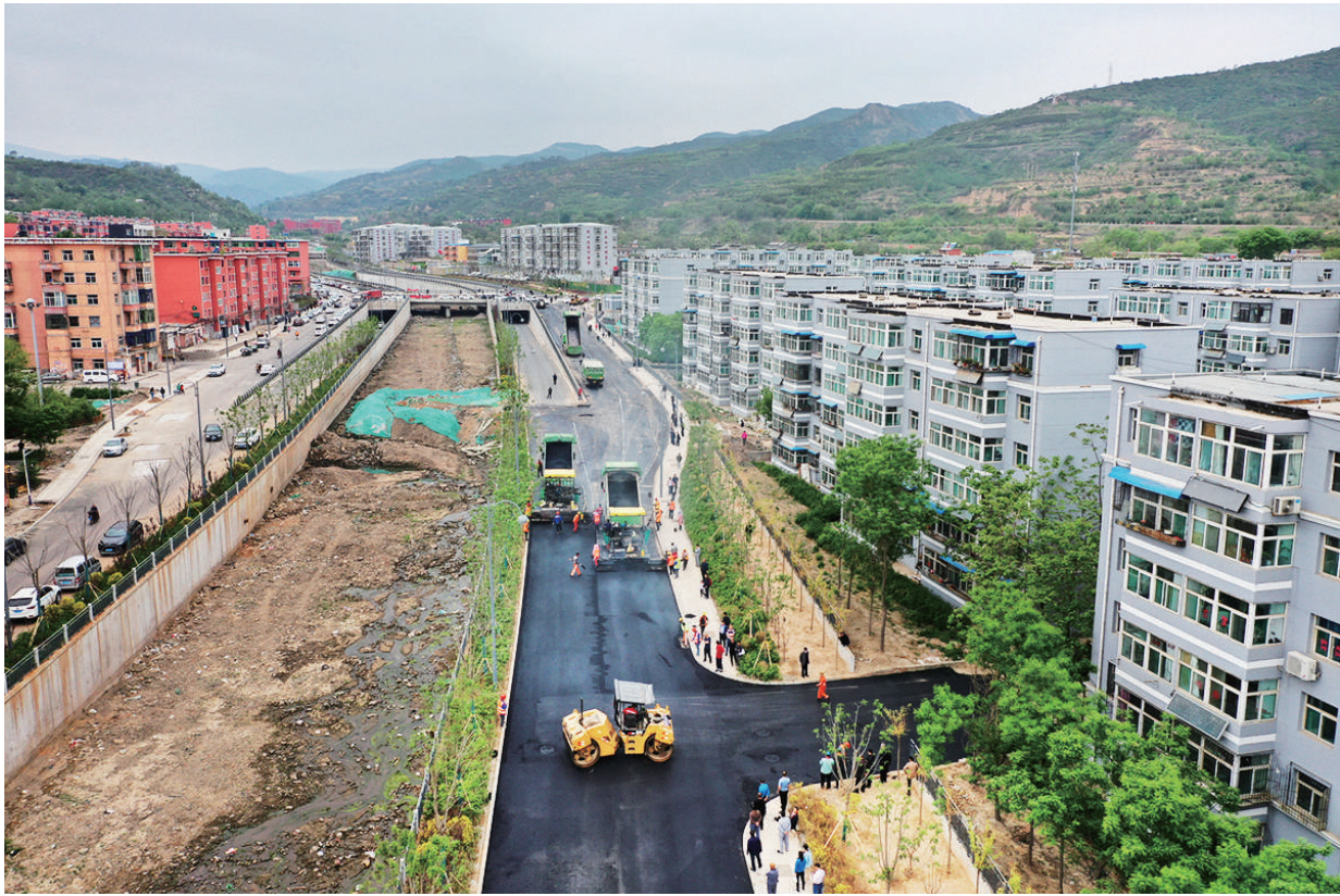
5月14日，在虎峪河道路改造及综合治理工程北岸，中铁大桥局的施工人员进行面层沥青的摊铺施工。作为续建工程，虎峪河西延工程，西起鸭崖底，东至白家庄路，全线单侧长度约5.4公里，南北两岸全线设跨河桥、下穿通道等。改造后西山地区的生态环境得到进一步改善，市民出行更加便捷。
