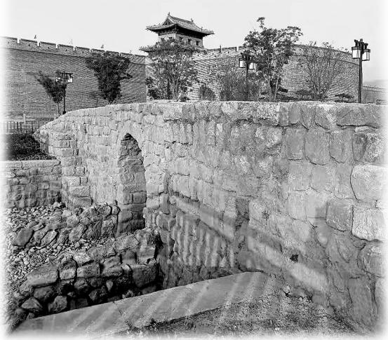
石桥为单孔横券式拱桥，是典型的民间建筑式石碹洞顶。它长7.7米、宽2.3米、高2.8米。从外观看，表面使用材料材质不一，青石、沙石混用。砌层也高低不一，没有一点规整度。在修缮中还发现，石桥基础不宽，也不坚固，两壁墙体厚薄不一。南半部有几处，更只是单层式墙体，中间是未夯实的松散的回填土。从塌露部分可明显看出，碹顶南部边沿，还有少量仅是一层石头垒砌。更让人不解的是，连白灰浆的使用，都是时有时无，有的地方根本看不见白灰，石块都是干砌。墙体外表也参差不齐，且未勾缝。在桥洞内壁修缮时，近旁还发现了几处人体尸骨碎块。从石桥修缮现场的桩桩件件判断或推断，石桥应是在一个非常时刻或紧急状态下施工完成，并延续下来的。在现场，还发现一通字迹无法辨认的石碑。碑身整体完整，高1.13米、宽0.58米、厚0.24米，形体规制均具有明代特征。但它与这座明代石桥一样，未能为我们留下只言片语。
