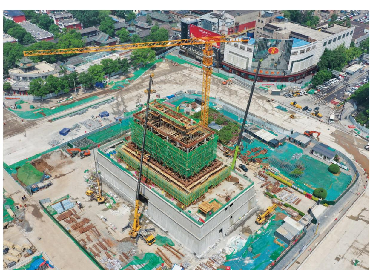
5月19日,五一广场改造工程现场,首义门的两层承台已完成主体结构施工,正在进行木结构城楼建设。复建的首义门为仿古建筑,占地面积约1800平方米,是文化太原、英雄太原的重要载体。
