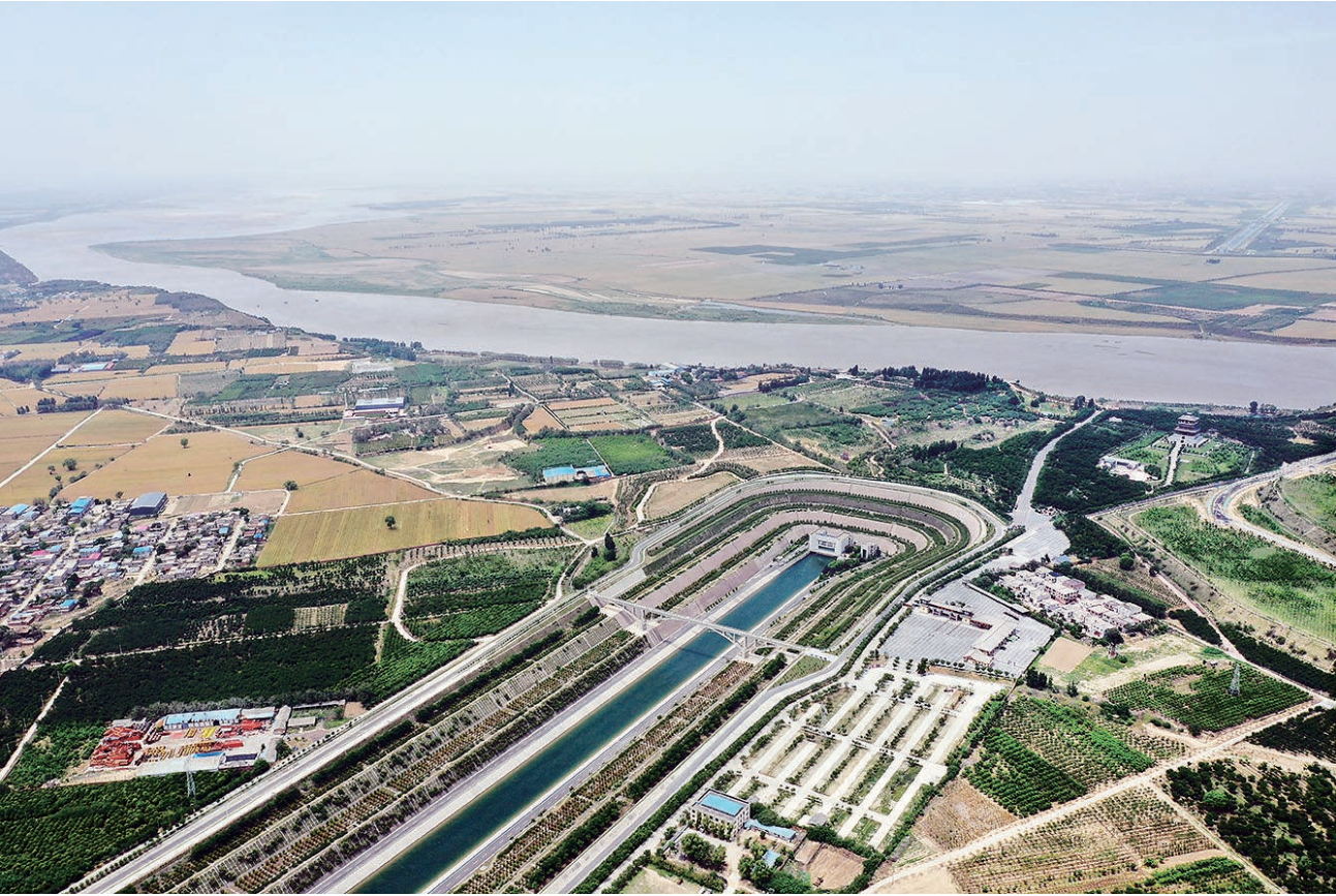
◀这是5月23日在河南省郑州市拍摄的南水北调中线穿黄工程(无人机照片)。 在郑州西北约30公里一个叫孤柏嘴的河湾处,黄河河底之下还藏着两条从南向北奔流的“河”。这一穿黄工程是南水北调中线的“咽喉”,也是国内首例用盾构方式穿越黄河的工程。从“咽喉”之地涌向黄河北岸的南来之水,为华北地区打开了“水龙头”,滋润了周边的城市。 新华社记者 李嘉南 摄
