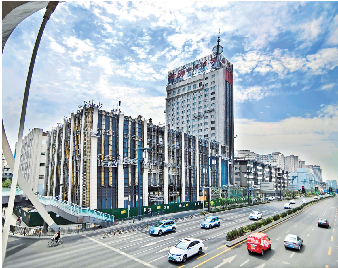
八月十二日,位于解放路钟楼街西口的汾酒大厦外幕墙装饰改造工程即将完工。张昊宇 摄
