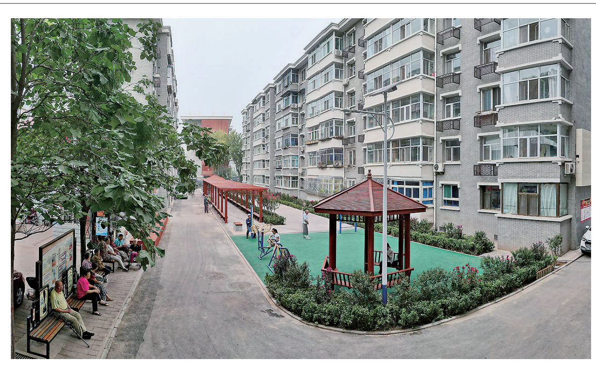
8月16日,五一路北社区西院,居民在刚改造好的花园里尽享惬意生活。该小区经过路面硬化、环境整治等措施,全面改善居住生活环境,让群众幸福感升级。贾鹏 米国伟 摄
