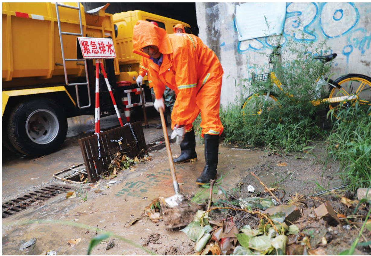
8月19日,市市政公共设施建设管理中心道路排水保障一所的工作人员在疏通雨水管道,确保及时排涝。降雨期间,该所人员在辖区重点路段,排查管道运行情况、清理周边杂物、利用高压射水车疏通排水管道。张昊宇 徐浩轩 摄
