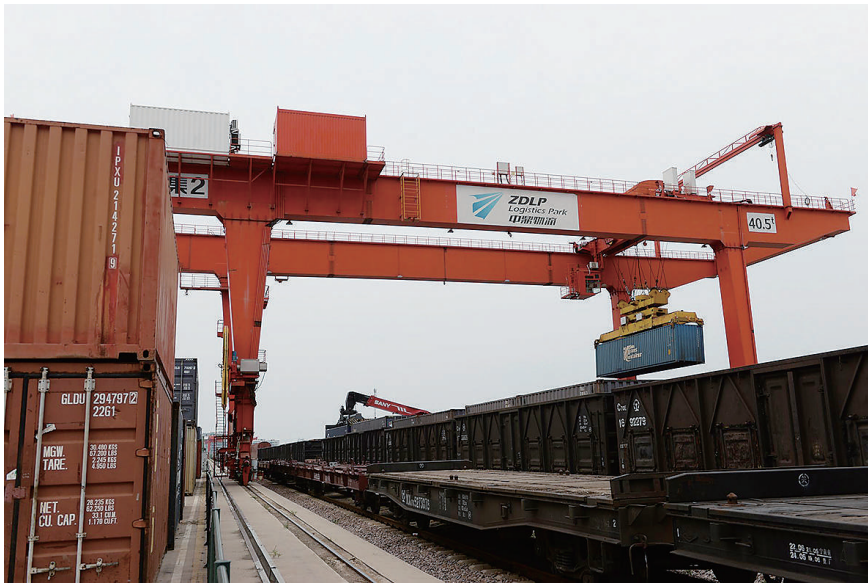
中鼎物流园内，塔吊正在作业。
