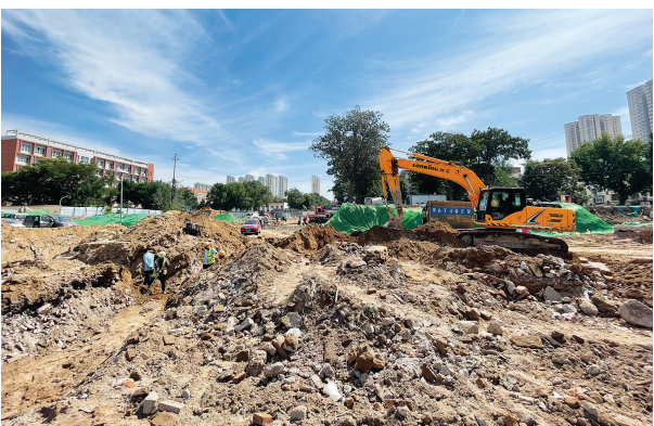
迎泽大街东延施工现场。邓寅明 摄
