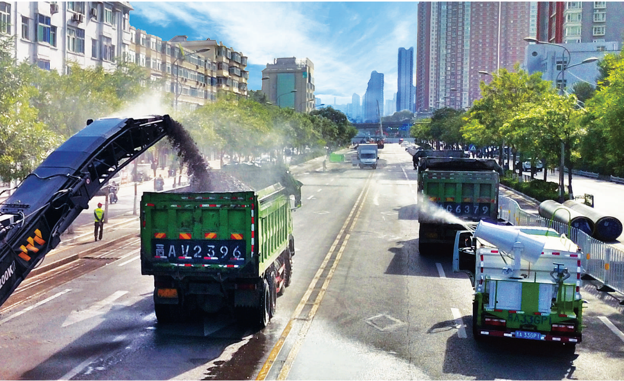
8月26日,胜利街(涧河路至新建路)道路改造施工现场,铣刨机对路面结构层进行铣刨。此次改造以地下管网的升级为主,天然气、热力管线以及雨污管网将得到全面提升。 李学军 摄
