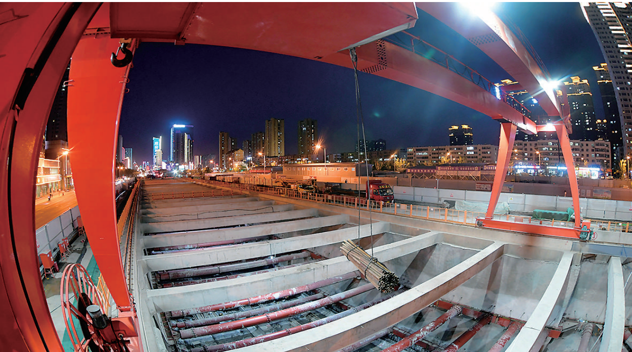
8月28日晚，位于迎泽西大街的太原地铁1号线102标段项目工地，中铁十二局集团的施工人员正在忙碌。目前，由该局承担建设的客运西站、金阳路站、小井峪站，钻孔桩围护结构、冠梁及混凝土支撑已完成，全线施工正在稳步推进。 赵世凯 赵桂军 摄
