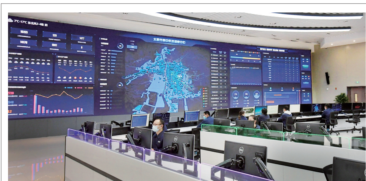
10月14日,新建成投用的太原市集中供热调度中心内,工作人员正在调试设备。该中心建有云数据中心机房、智慧热网系统、“三供一业”控制系统等,实现了调度指挥、热网调控、生产监控、信息显示的统筹。赵世凯 摄
