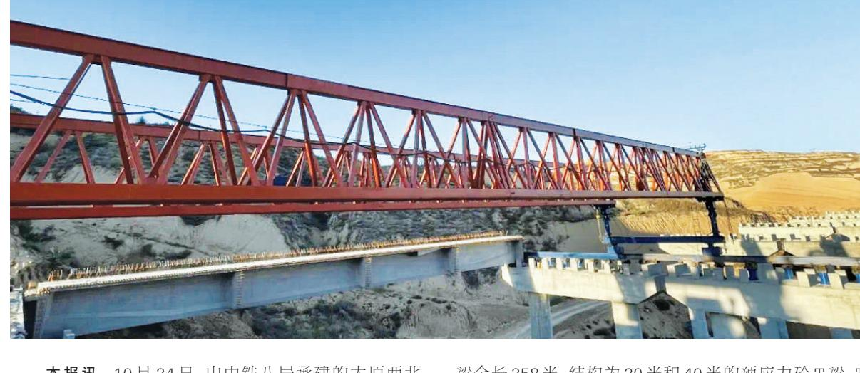
本报讯 10月24日,由中铁八局承建的太原西北二环高速ZH07标八字足大桥首榀T梁架设成功,项目整体进度再次向前推进了一大步,为后续工程顺利施工奠定了基础。
