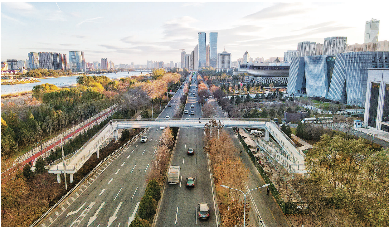
11月14日,滨河西路市图书馆前的人行天桥与汾河景区的“五彩斑斓”共同构成一幅和谐的美景。今年我市新建10座人行天桥,截至目前,已有8座投入使用。米国伟 摄
