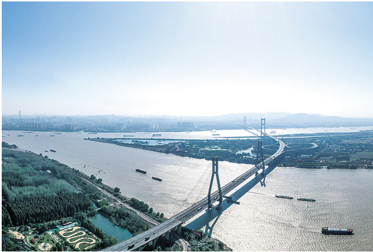
润扬长江大桥沿江风光（11月10日摄，无人机照片）。近年来，江苏省以“生态优先、绿色发展”为目标推进长江生态环境保护修复工作，拆除沿岸非法码头、关停沿岸污染企业、修复长江两岸生态湿地。长江江苏段造林绿化和湿地保护渐见成效，江滩湿地生态优美、江岸形态多样，让美丽长江再现新景色。
