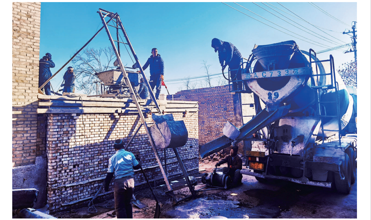
图为阎家营村受损房屋重建工地。
