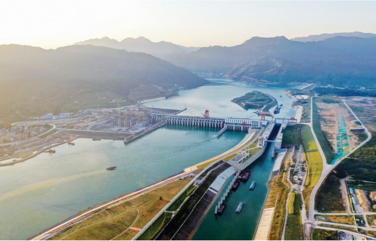
这是建设中的广西大藤峡水利枢纽工程(11月26日摄，无人机照片)。建设中的大藤峡水利枢纽工程位于广西桂林市西江流域上的黔江河段，是国务院确定的172项节水供水重大水利工程之一。
