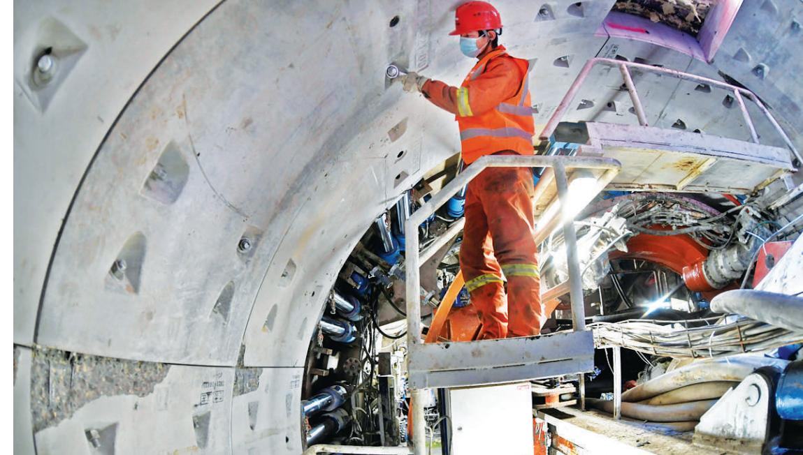
11月30日,太原轨道交通1号线龙城大街东站至武宿机场站,开挖直径6.4米的“汾晋一号”盾构机分体始发。该区间全长2.73公里,是地铁1号线最长的盾构区间。
