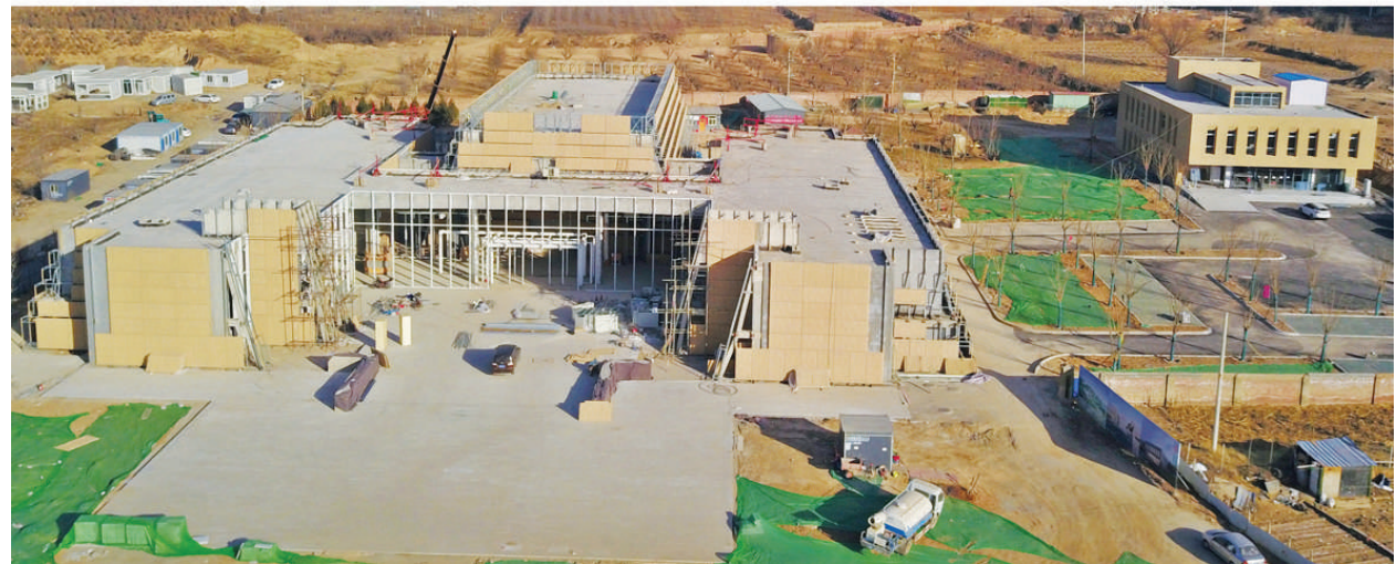
12月21日，建设中的太原北齐壁画博物馆，主体雏形初现，工人正在加紧安装外立面，各项工程有序推进。该馆位于太原市迎泽区王家峰村，是依托北齐徐显秀墓的原址保护，结合北齐壁画和其他文物的保护、研究、利用、管理为核心的遗址博物馆。李学军 宋卫东 摄
