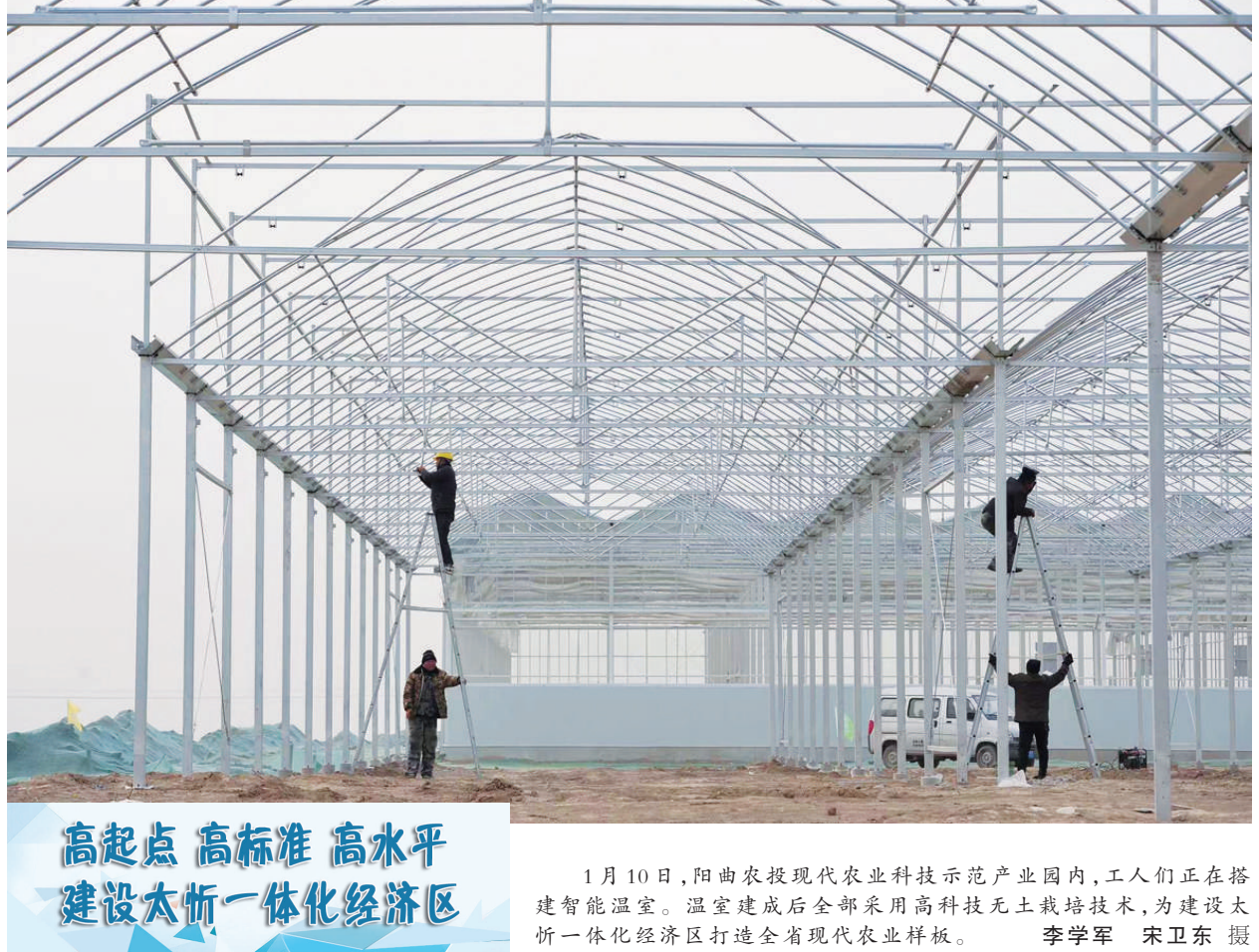
1月10日,阳曲农投现代农业科技示范产业园内,工人们正在搭建智能温室。温室建成后全部采用高科技无土栽培技术,为建设太忻一体化经济区打造全省现代农业样板。李学军 宋卫东 摄
