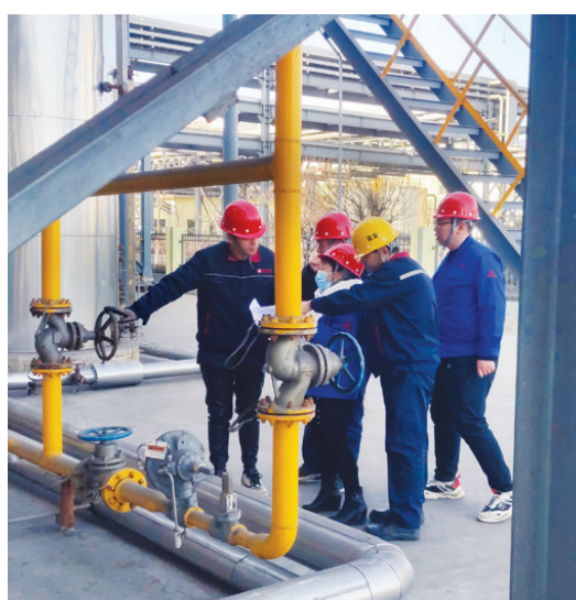
相关部门工作人员检查企业压力管道。
