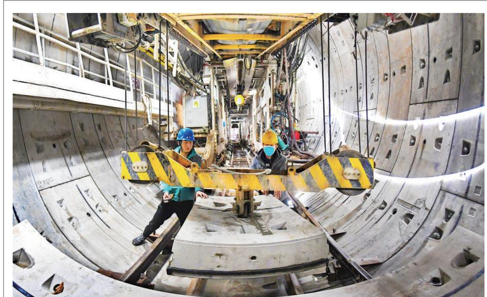
2月23日,太原地铁1号线大南门站——桃园路站盾构区间内,奋进1号盾构机正在有序施工。为确保年度目标顺利完成,施工人員铆足干劲,全力加速。米国伟 摄
