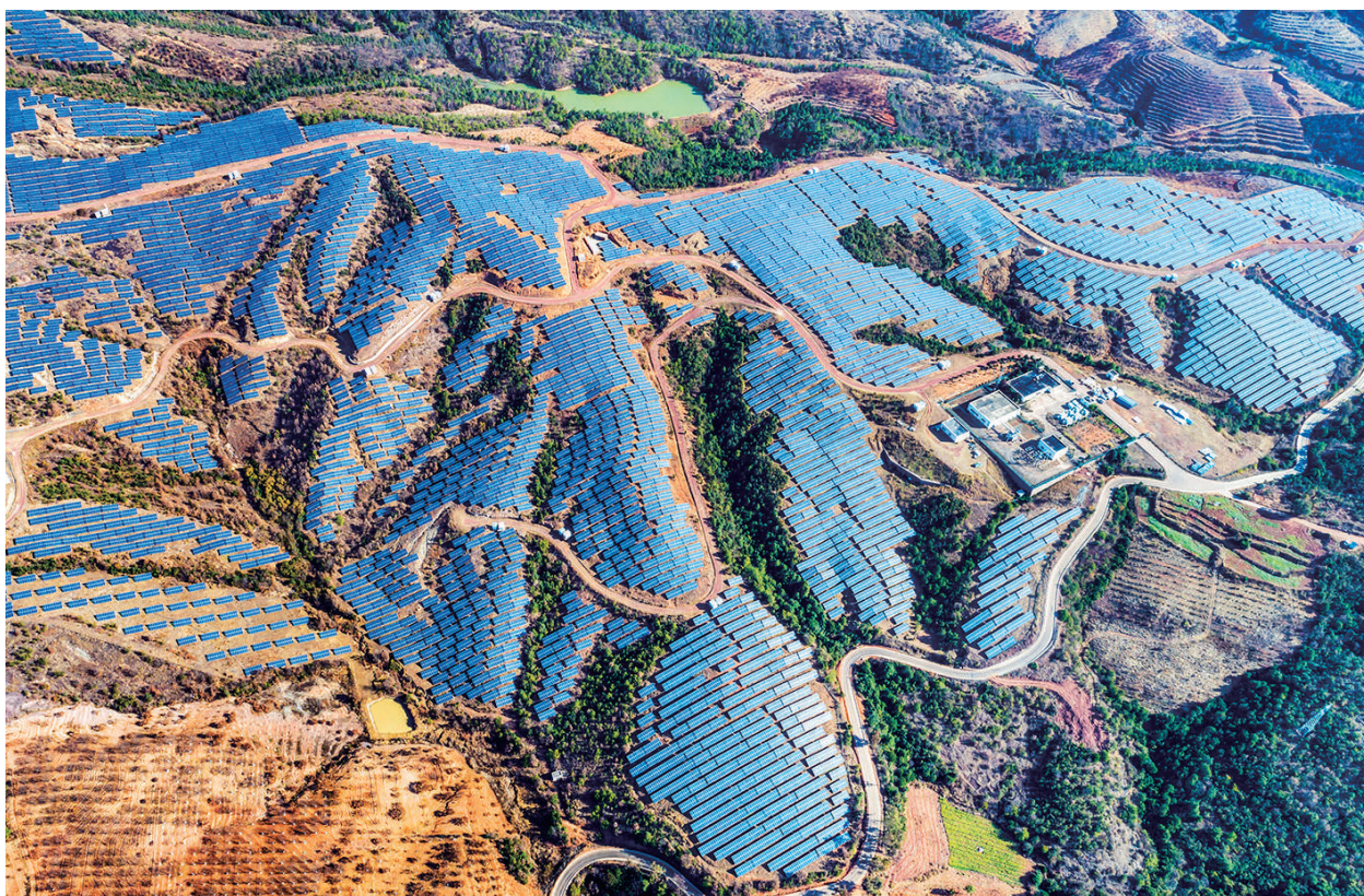
2022年2月16日拍摄的位于云南省楚雄彝族自治州永仁县维的乡的一处光伏电站(无人机照片)。 新华社发
