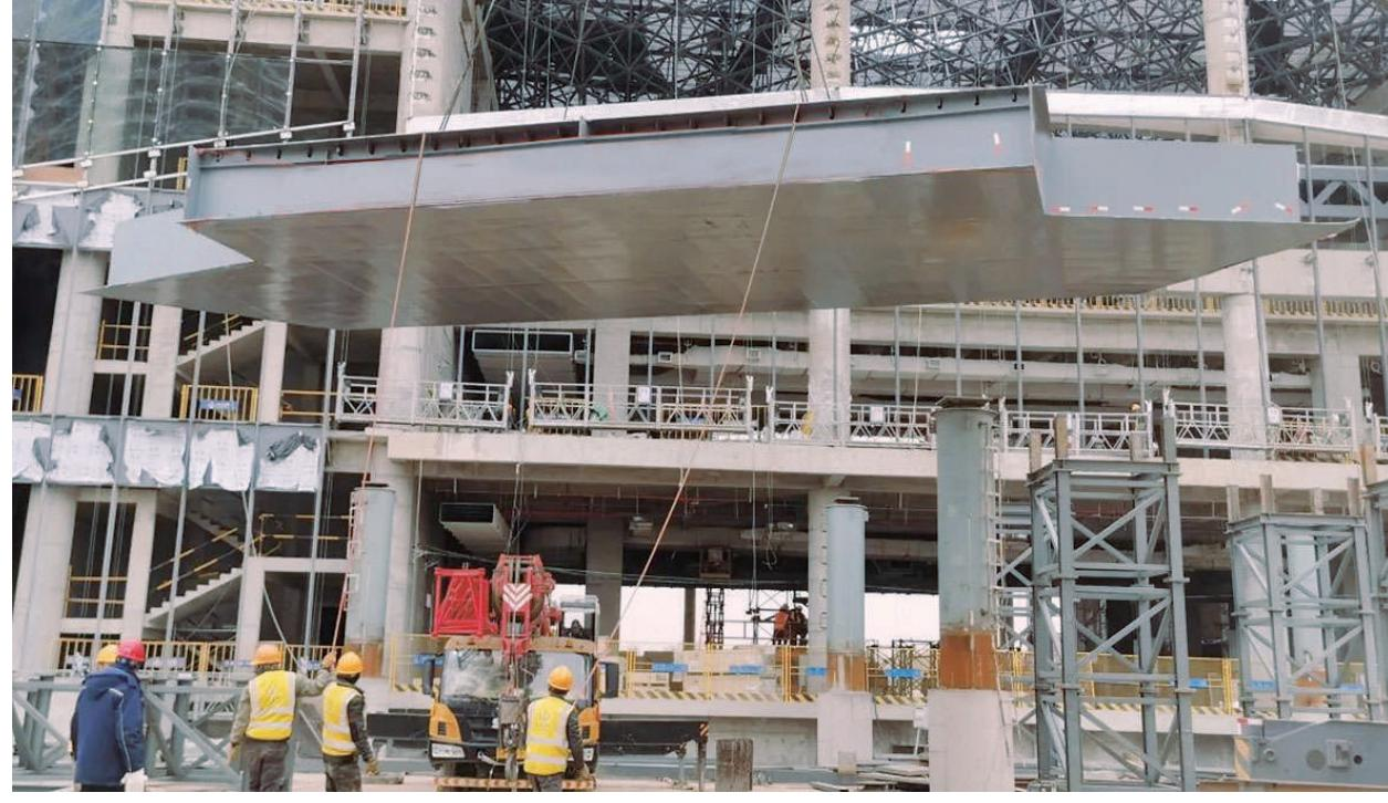
日前，在山西建投潇河公司承建的山西·潇河新城项目现场，一根长30.6米、宽7.02米、重约38吨的钢箱梁缓缓升起，历经1个小时，成功吊装落位。
