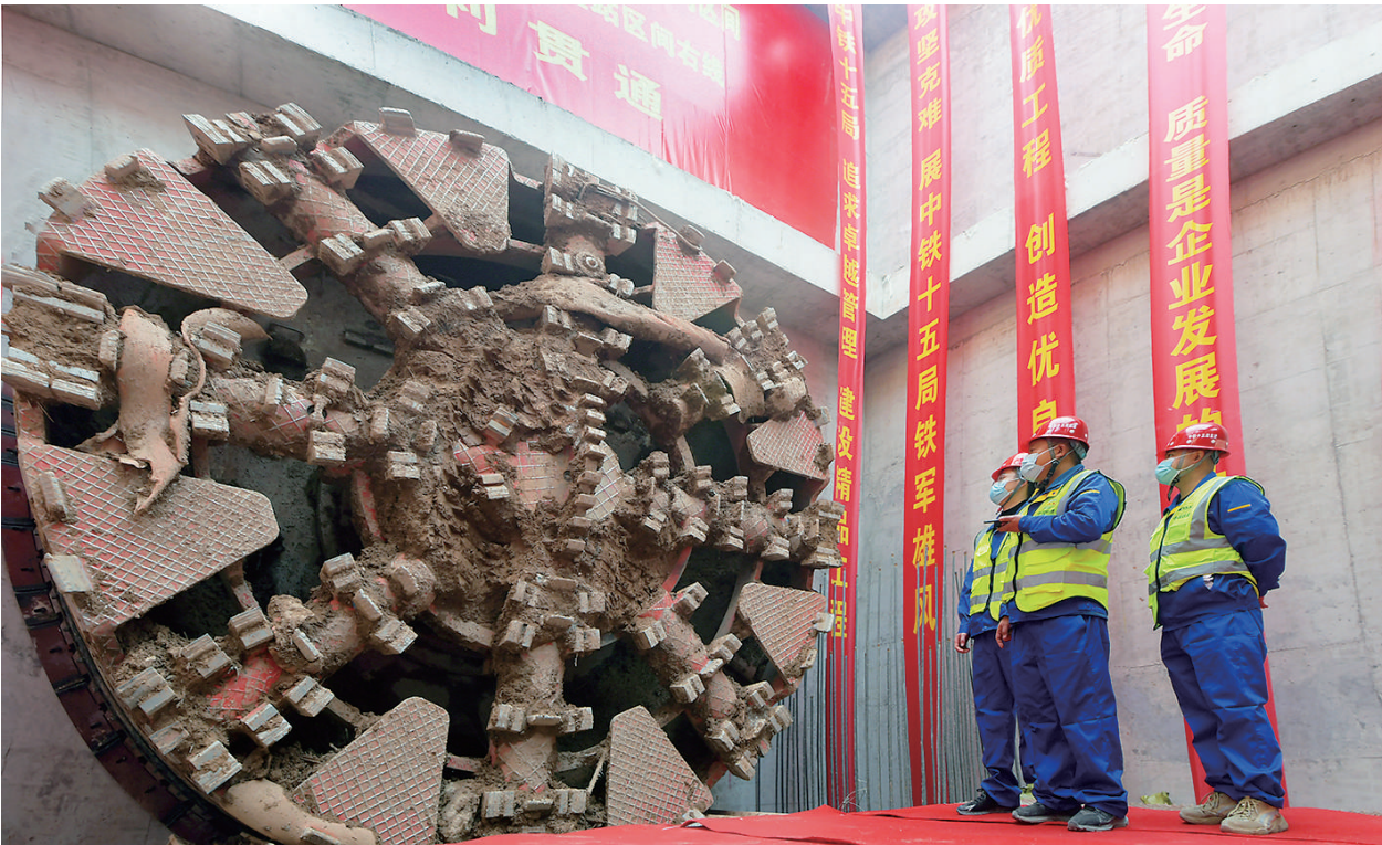
3月29日，由中铁十五局集团有限公司承建的太原轨道交通1号线南内环东街站——东太堡站右线盾构区间顺利贯通。这是全线首个贯通的盾构区间，全长888米，标志着1号线盾构区间施工取得突破性进展。 赵世凯 吴英 摄
