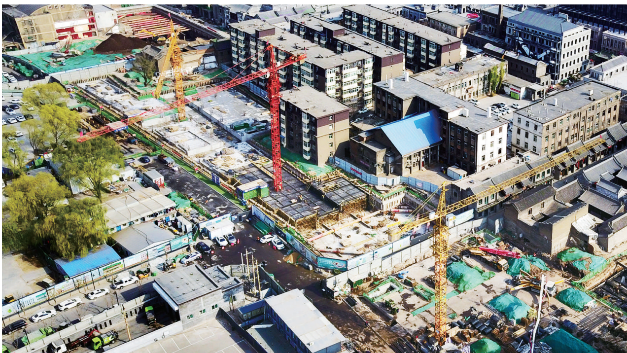
4月5日,钟接街片区修缮保护工程(二期)项目勘察后街施工工地,建设者正加紧施工。作为太忻一体化经济区(迎泽板块)集中开工的首批15个重点项目之一,钟接街二期主要包含钟接街周边街巷改造,将丰富整个街区的文化氛围,实现提档升级。李学军 牛利敏 摄
