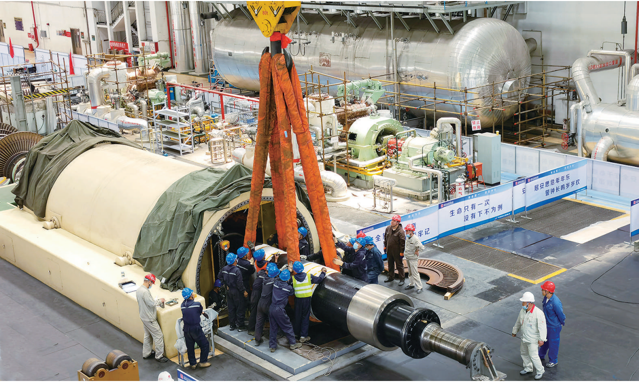
5月29日,大唐山西发电有限公司太原第二热电厂对13号机组进行A类检修,以保证机组安全运行。
