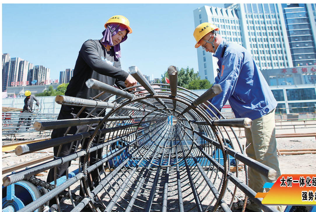
6月14日,太忻经济一体化(太原区)杏花岭片区杏花岭区文化服务中心建设工地,工人正在紧张忙碌着。该中心建成后将成为综合性现代化公共文化服务基础设施。 徐浩轩 郝晨光 摄
