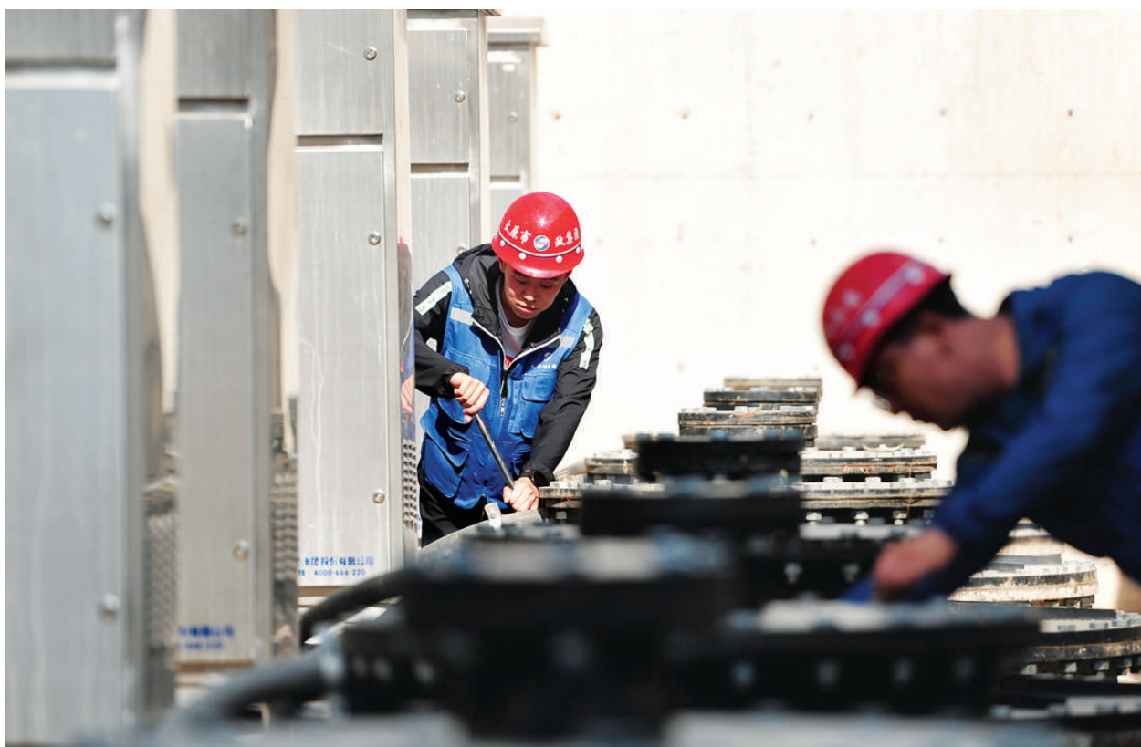
6月19日，千峰路雨水泵站主体结构已建设完成，工作人员正在调试设备。该泵站投用后，将有效缓解城市内涝的发生。
