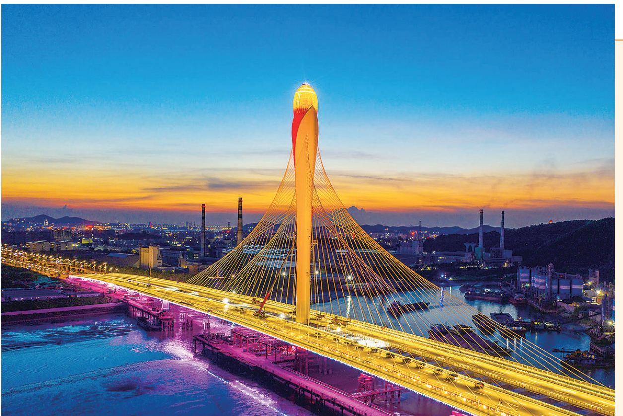
夜幕下的东莞滨海湾大桥(6月28日摄,无人机照片)。6月30日,由中铁大桥局承建的广东东莞滨海湾大桥正式通车。滨海湾大桥地处被定位为粤港澳大湾区协同发展特色平台的东莞滨海湾新区,以东莞市花玉兰为创意元素,上跨磨碟河入海口,为独塔拉索面斜拉桥,全长973.6米。新华社发
