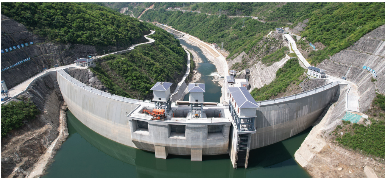
引汉济渭工程三河口水利枢纽工程(2022年4月19日摄,无人照照片)。 新华社发
