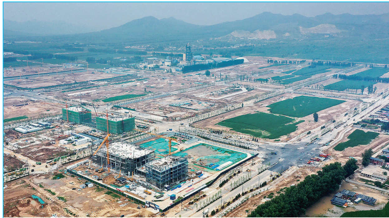
经过300余名建设者两个多月、24小时不间断施工,7月19日,太忻双碳产业科技园展示中心雄姿初显。该园区是一座围绕双碳产业研发、应用及产品展示的高科技园区,也是大盂产业新城首批启动的项目之一。 韩双喜 徐浩轩 摄
