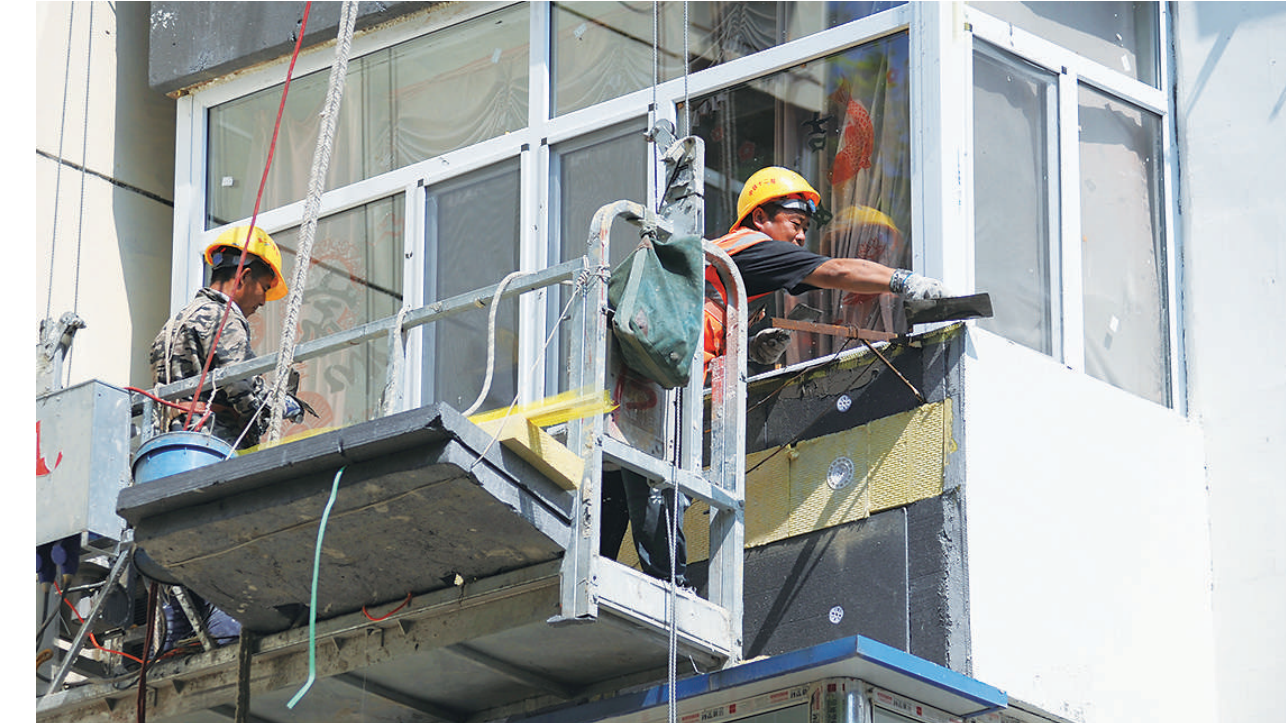
7月20日,杏花岭区黑土巷铁路小区,太原既有居住建筑节能改造二期项目施工人员在居民楼外立面加装保温层。该项目将改善居民居住环境,减少碳排放,让城市环境更美好。 徐浩轩 郝晨光 摄
