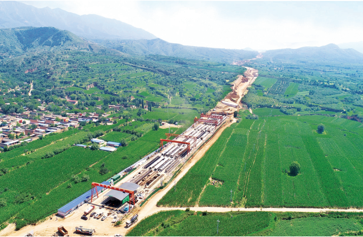
7月21日,由中铁十七局集团承建的大忻大道(忻州段)第一标段正在加紧施工。该标段是大忻大道(忻州段)的起点,目前,道路的土方工程和地下桩基已全部完成,转入上部结构施工阶段。 赵世凯 武 慧 摄
