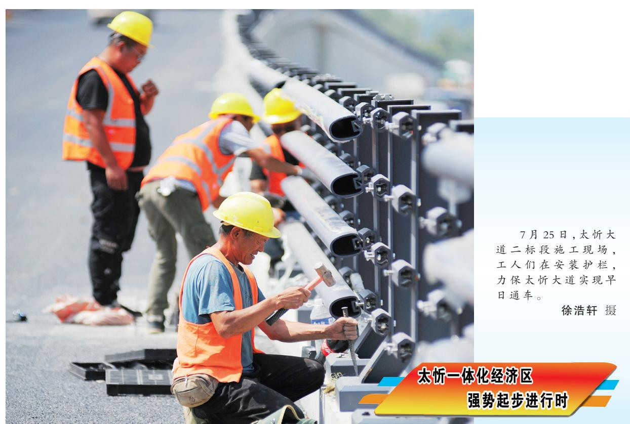
7月25日，太忻大道二标段施工现场，工人们在安装护栏，力保太忻大道实现早日通车。
