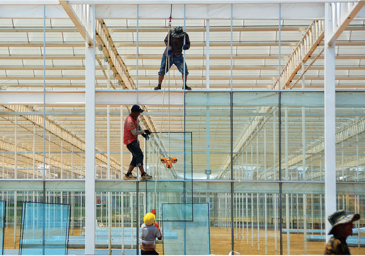
8月4日,阳曲县现代农业科技示范产业园工地上,工人们正在给温室安装玻璃墙。该产业园玻璃温室采用智慧农业技术和无土栽培水肥一体化技术,种植将全部实现智能化。 李学军 宋卫东 摄
