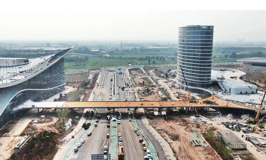
图为吊装完成的193米大跨度钢结构连桥。
