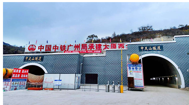
图为太原西北二环高速中足山特长隧道。
