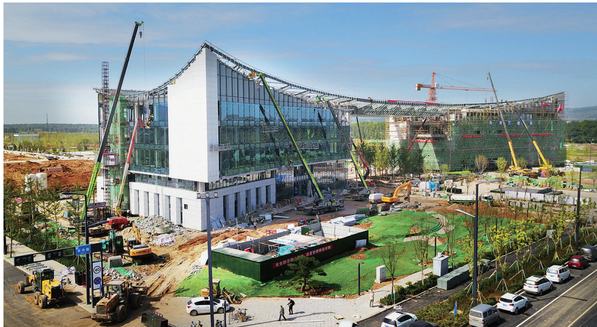
太原科创驱动中心建筑工地,施工人员进行玻璃幕墙安装和内部装修。 李学军 宋卫东 摄
