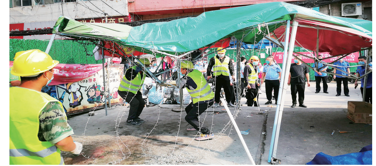
动,严厉打击占道经营、违章乱建等行为;查处无证、无照经营的发廊、足浴、网吧、棋牌室等易藏污纳垢的场所,清除黄、赌、毒等社会丑恶现象,消除私拉电线、违章乱建等 消防隐患,不断净化“城中村”的治安环境,早日还居民群众一个干净、安全、清朗的社区。 上图:拆除占道经营。(司勇文/摄)
