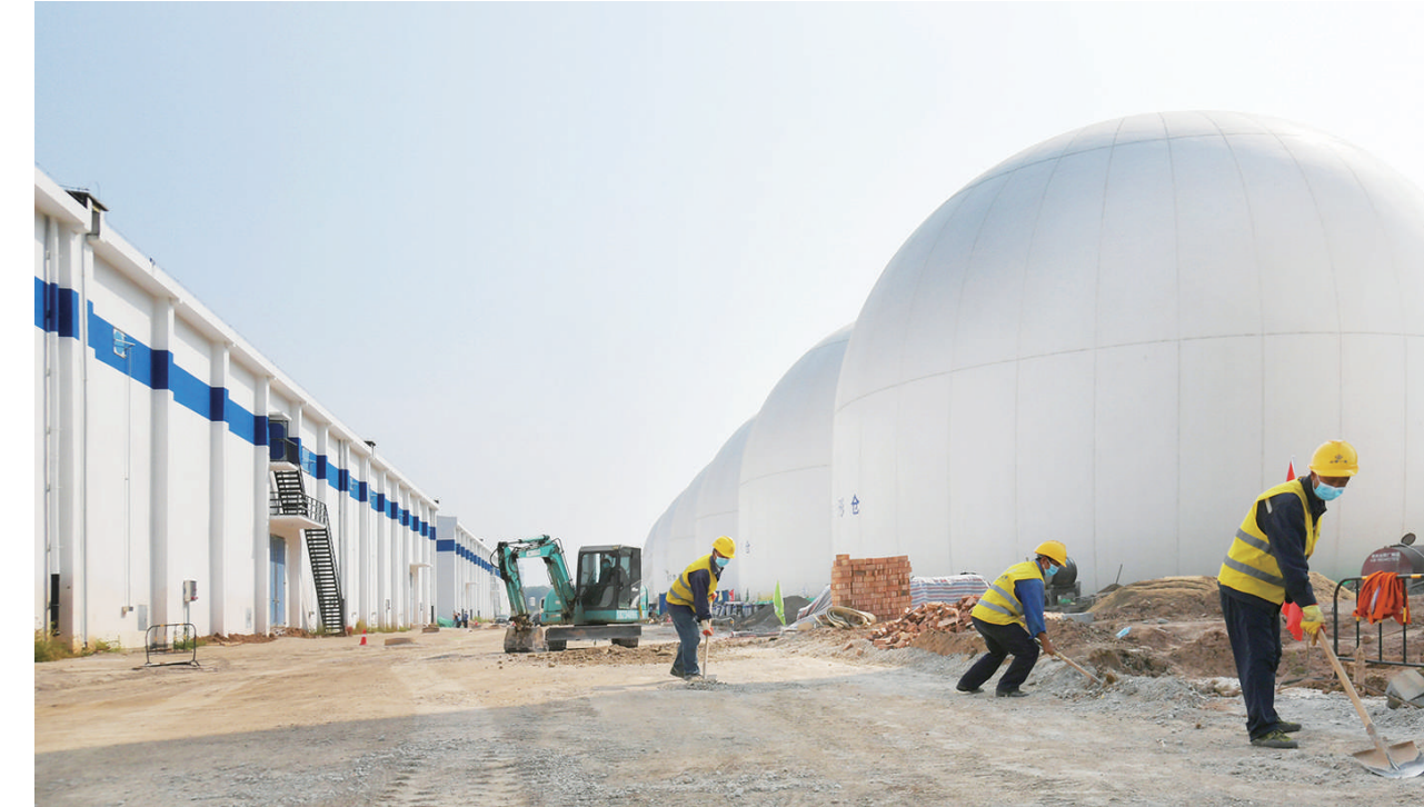
9月18日，位于阳曲县的市粮食物流产业园区（一期）项目加紧建设。该园区集粮食仓储、加工、物流、应急配送等功能于一体。目前，24座平房仓基本建成、6座球形仓正在进行结构层施工，其他配套设施建设接近尾声。赵世凯 摄
