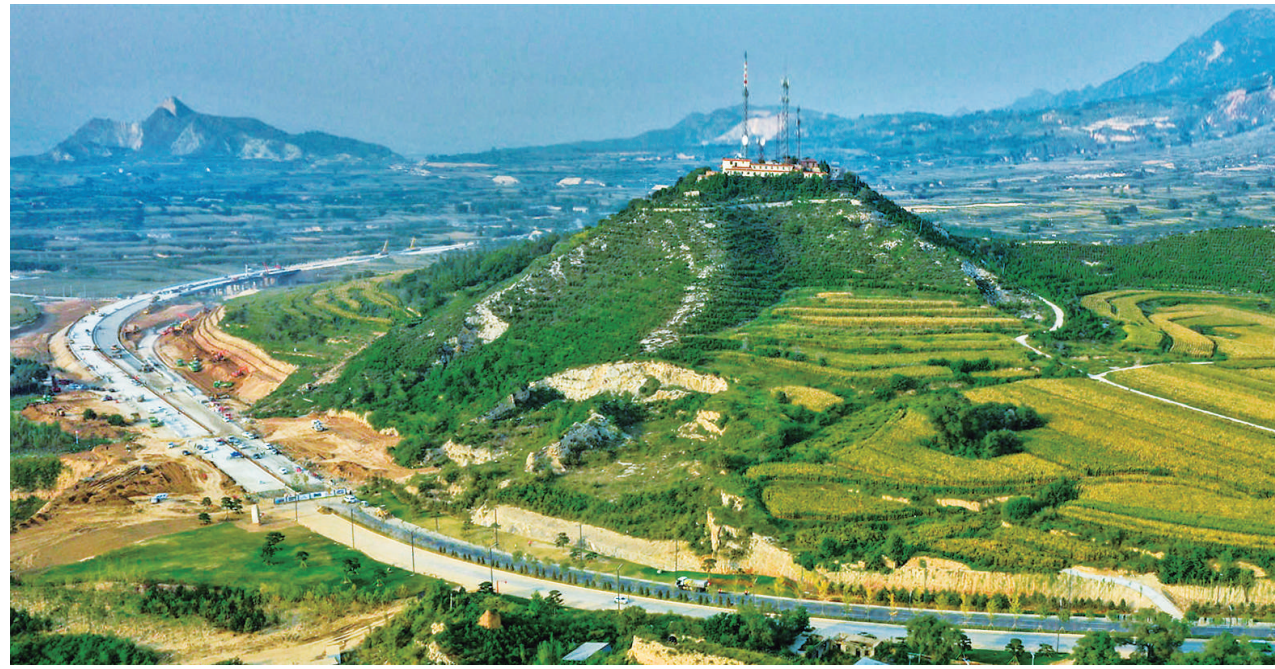
9月25日,太忻大道大盂镇石岭关(太原与忻州交界处)段,建设者加班加点对交接路面配套设施进行收尾。据了解,太忻大道(忻州段)起点位于忻府区东曲村西,终点位于忻州市与太原市交界石岭关处。(韩双喜 摄)
