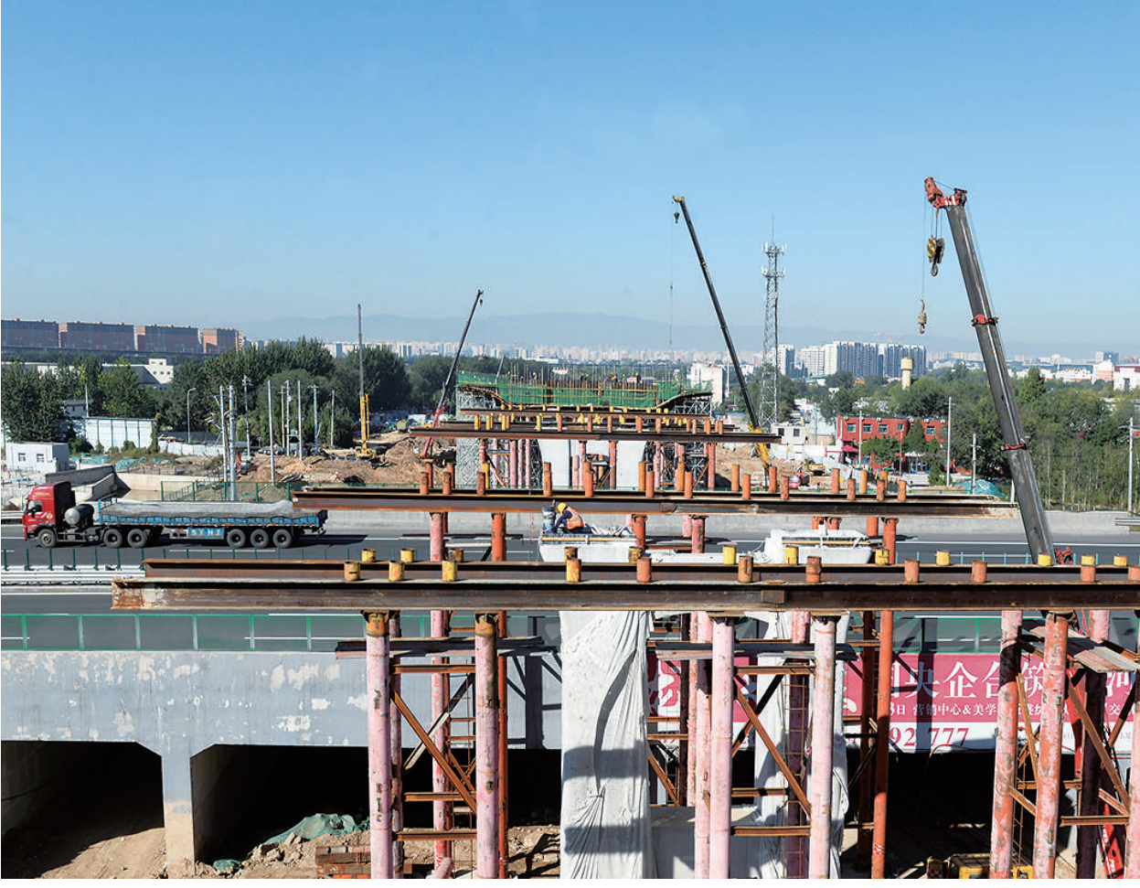
10月12日,龙城大街打通工程现场,建设者加紧施工。目前,跨二广高速桥下部结构已全部完工,正在进行上部结构的施工。建成后,将缓解太榆路交通压力,使太原、晋中两地的通行更便捷。李学军 牛利敏 摄
