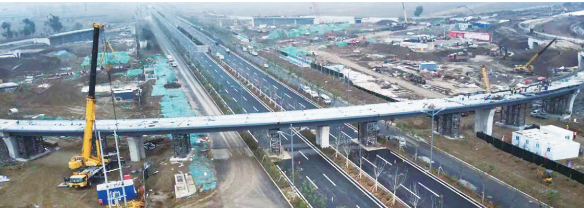
四十米钢箱梁匝道桥。图为成功合龙的小牛线西延一百
