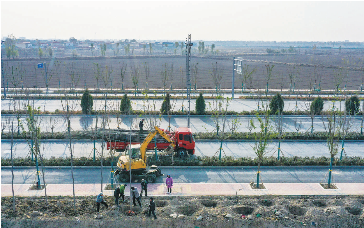
11月5日,滨河东路南延二期主体工程已经完工,施工人员进行道路绿化。
