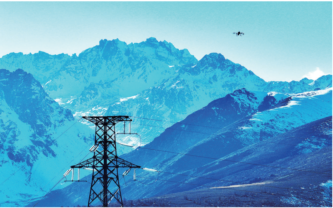
近日，在云南省迪庆藏族自治州德钦县，无人机对35千伏永德（德钦到明永）线路完成自主巡检。这标志着云南35千伏及以上输电线路实现无人机自主巡检全覆盖，9万公里输电线路均可采用无人机自主巡检。图为无人机在梅里雪山巡检（2022年11月17日摄）。新华社发
