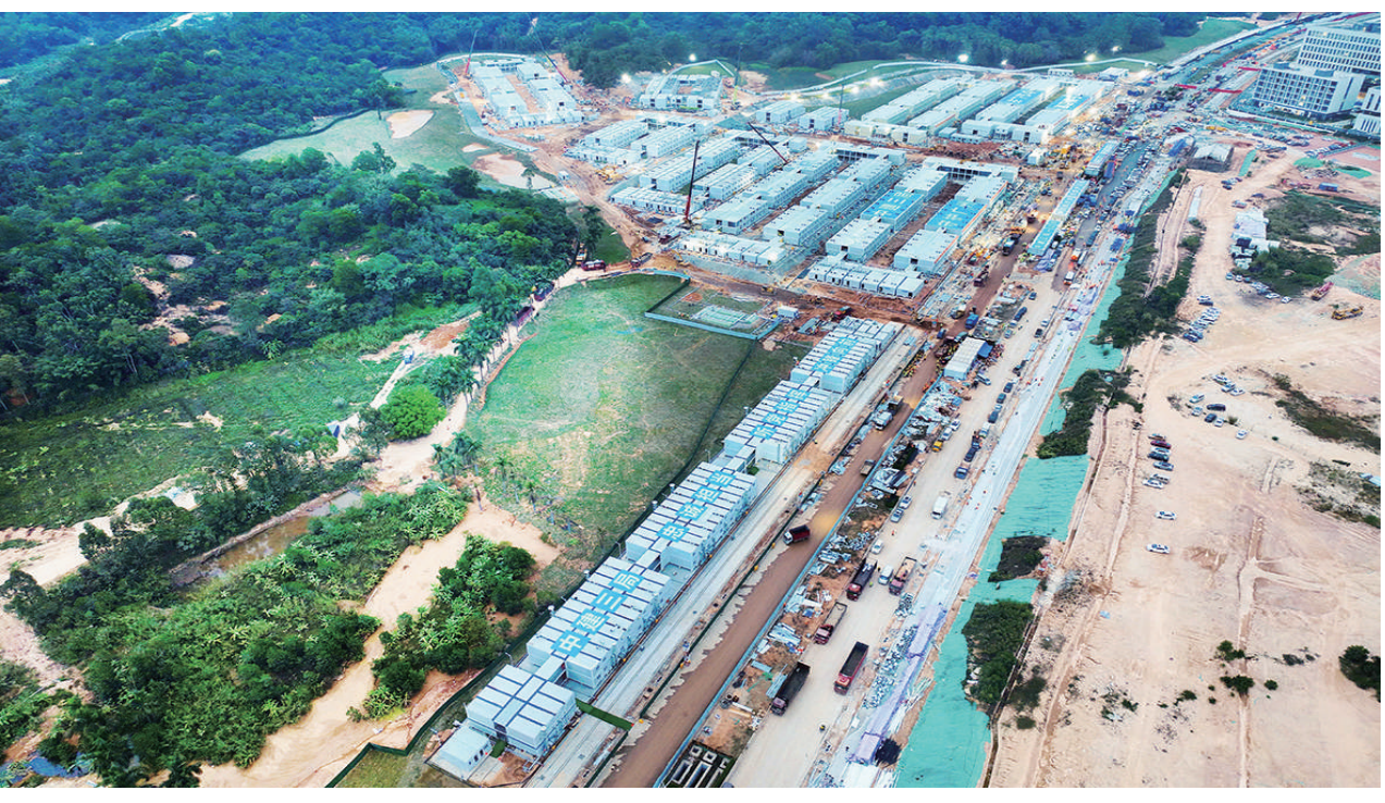
这是11月21日拍摄的广州黄埔区中新知识城方舱医院项目（无人机照片）。
