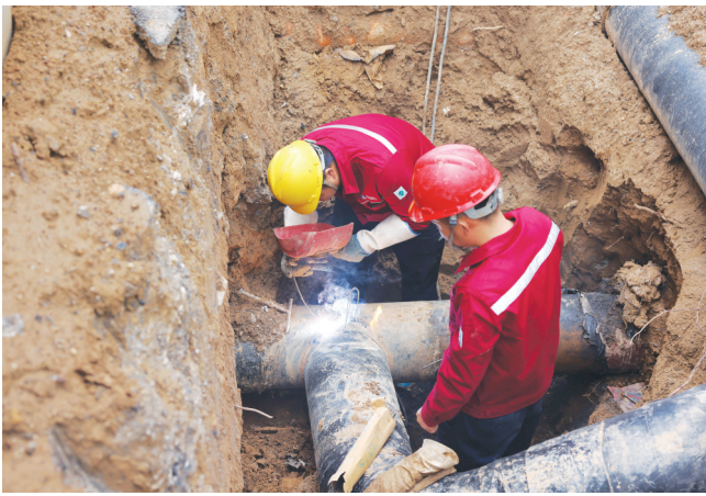
老旧燃气管线改造
